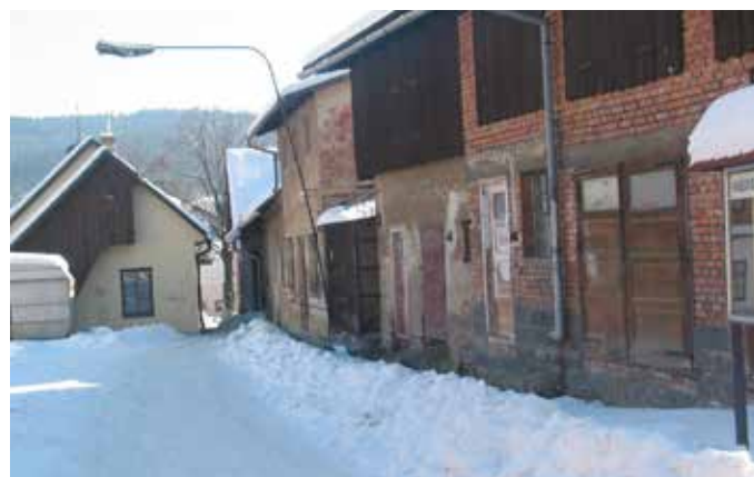
Obr. 28 – Původní stav Zákostelí. Foto Valaškokloboucké podnikatelské centrum
