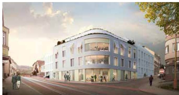
Obr. 32 – Dům na rohu po rekonstrukci, navrhovaný bytový dům. Zdroj Valašsko kloboucké podnikatelské centrum
