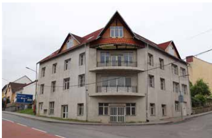
Obr. 31 – Dům na rohu před rekonstrukcí. Zdroj Valašsko kloboucké podnikatelské centrum
